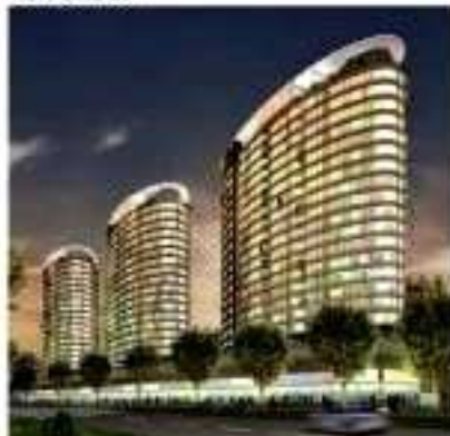
Tri veže: Termín ukončenia - koniec roku 2010; Vzhľad Bajkalskej ulice výrazne zmenia rozostavané 24-poschodové tri rovnaké vežiaky.
